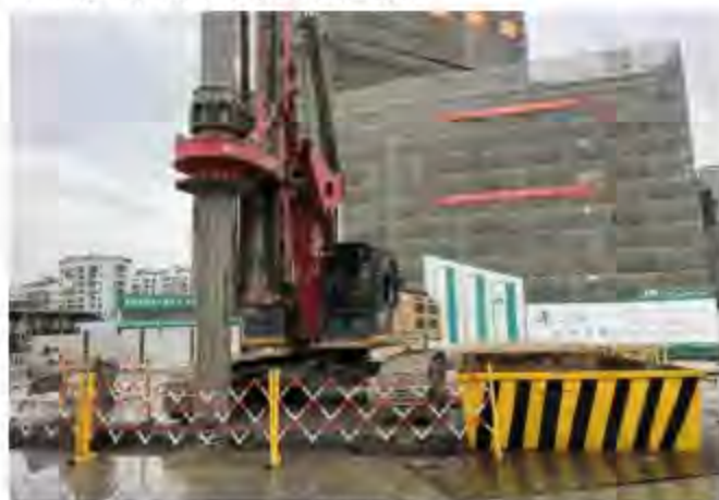
图 9 旋挖机成孔施工
