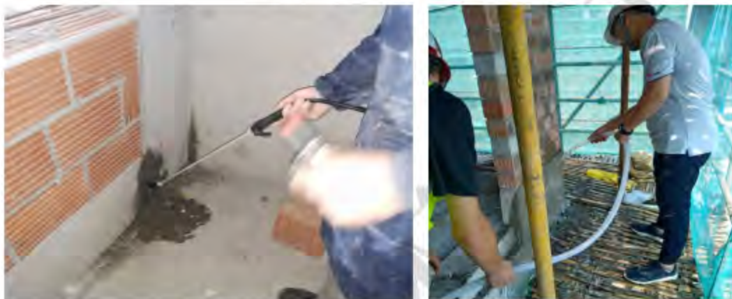
图 35 反坎浇筑前应充分冲洗干净
