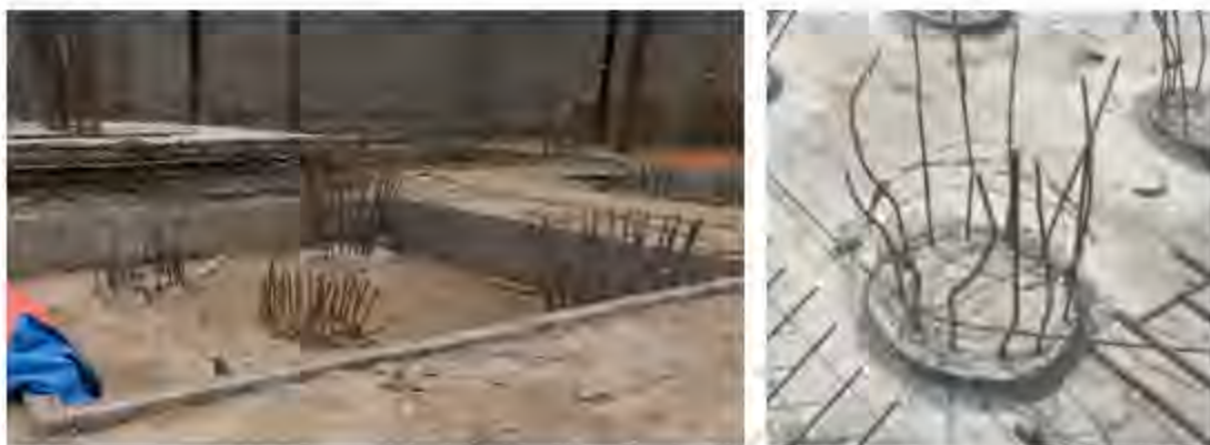
图 8 钢筋笼定位不准
