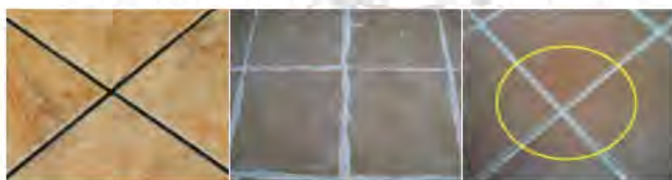
图 43 接缝采用填缝剂处理
