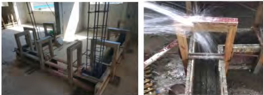
图 34 定型化夹具加固
