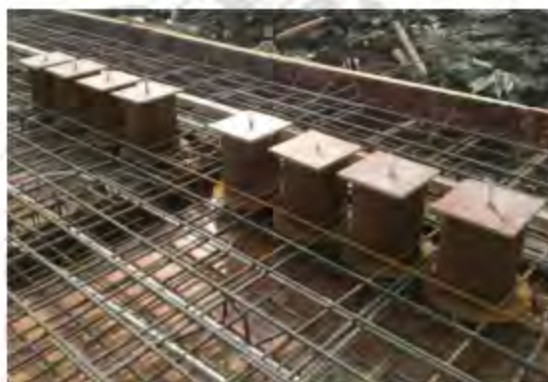
图 47 采用螺杆固定
