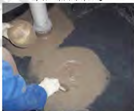
图 48 采用分层封堵
