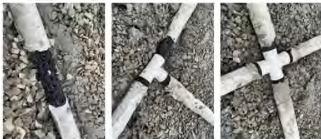
图4 塑料盲管各转折点连接实景图
