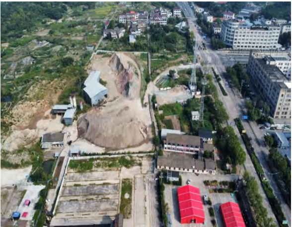
1. 浦江鑫鼎建筑废料处置利用有限公司
