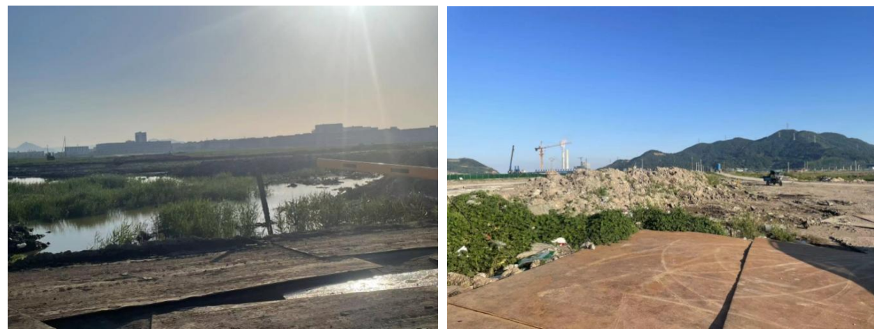
图3.4-2 乌龟岛工程渣土临时消纳场现场照片
