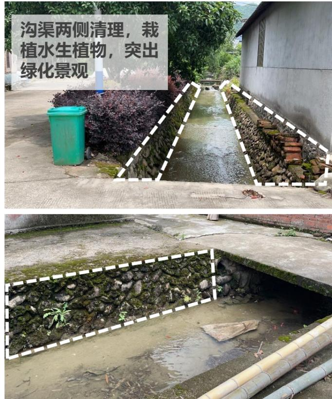
东坞村村域范围内河道、沟渠等水系总体现状条件较好，水系驳岸较为一般，本次规划将重要区域河道驳岸梳理采用自然生态砌块驳岸形式和自然缓坡的形式，结合水生植物种植，营造水生及半湿生植物环境，提升河道景观性及自然水体净水、雨水调蓄作用
