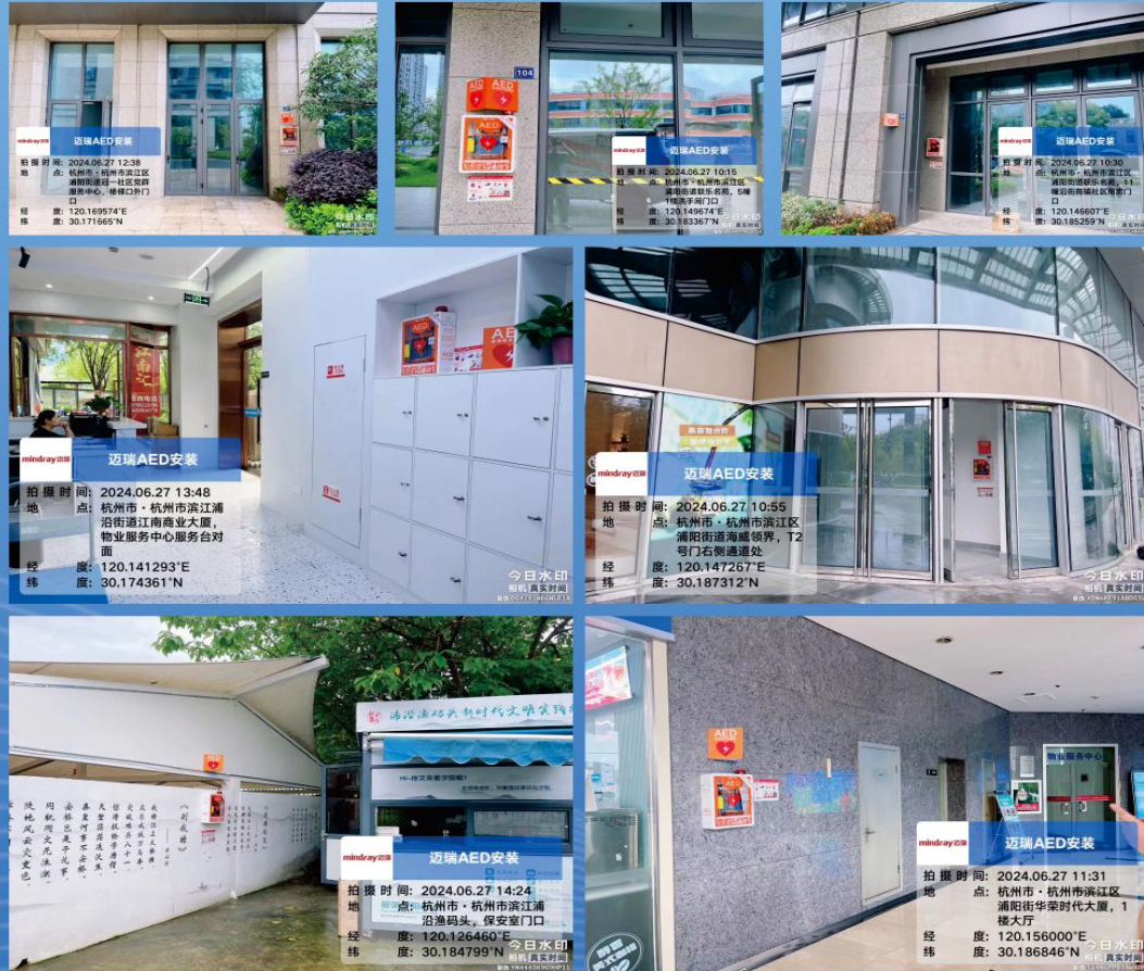
AED心脏除颤仪现场安装照
