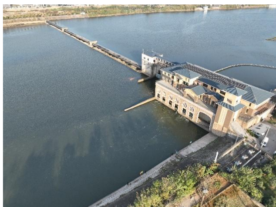
图 2.4-2 石柱头水利枢纽 1
