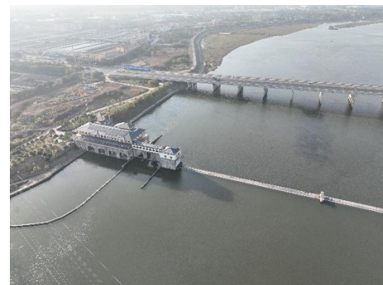
图 2.4-3 石柱头水利枢纽 2
